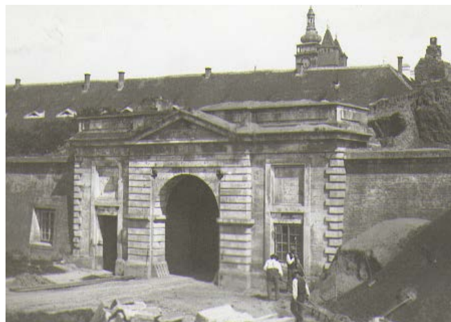
Abriss des Mährischen Tors
